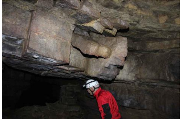
Felice Bellio, mentre ispeziona alcune parti della galleria. Si noti l'instabilità della volta, estremamente pericolosa.
