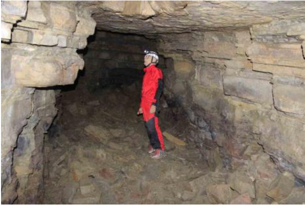
Felice Bellio, mentre ispeziona alcune parti della galleria. Si noti l'instabilità della volta, estremamente pericolosa.
